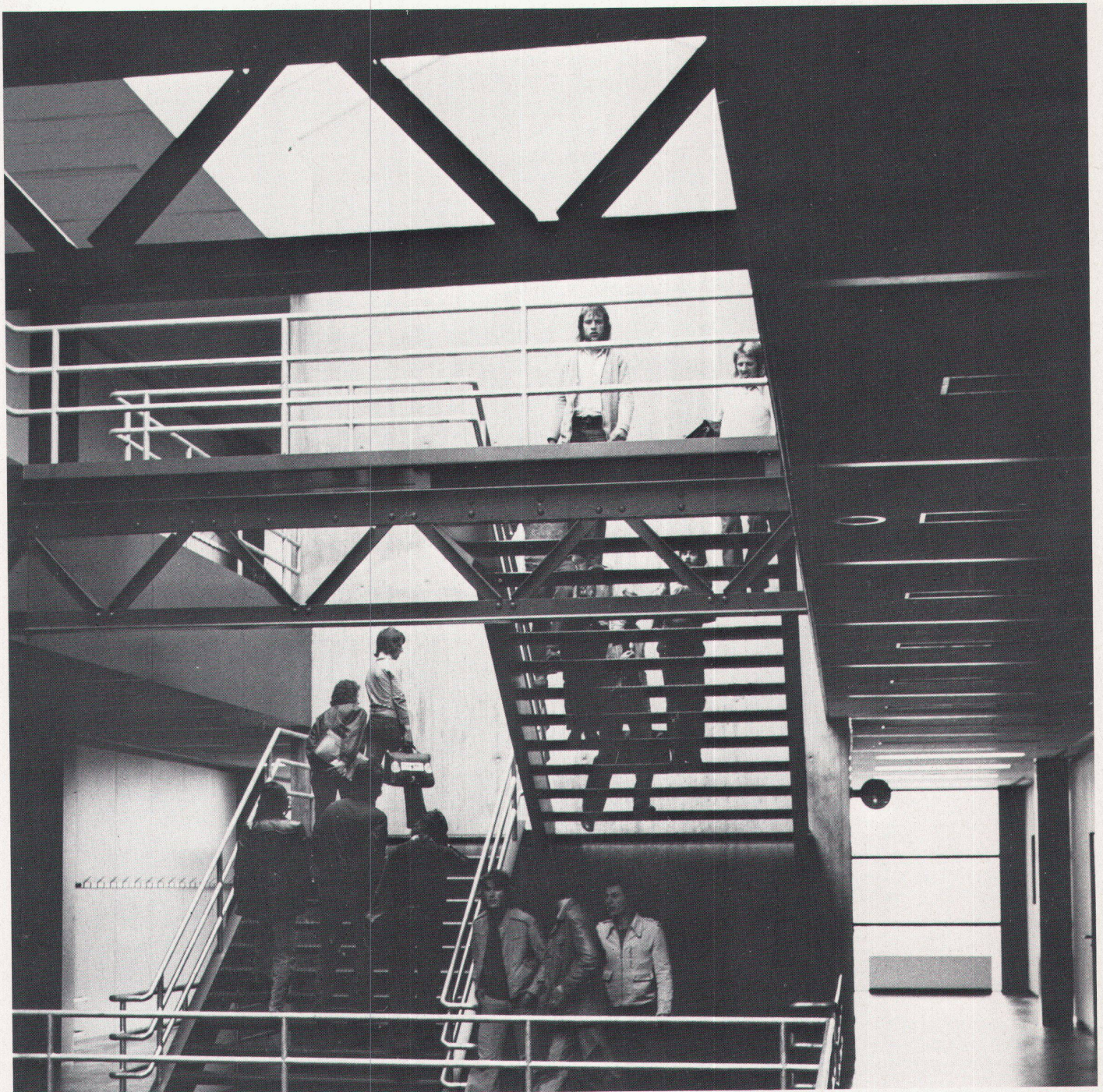
Treppenhaus: Metallkonstruktion des zentralen Lichthofes, farblich gestaltet durch W. Müller-Brittnau, Zofingen
