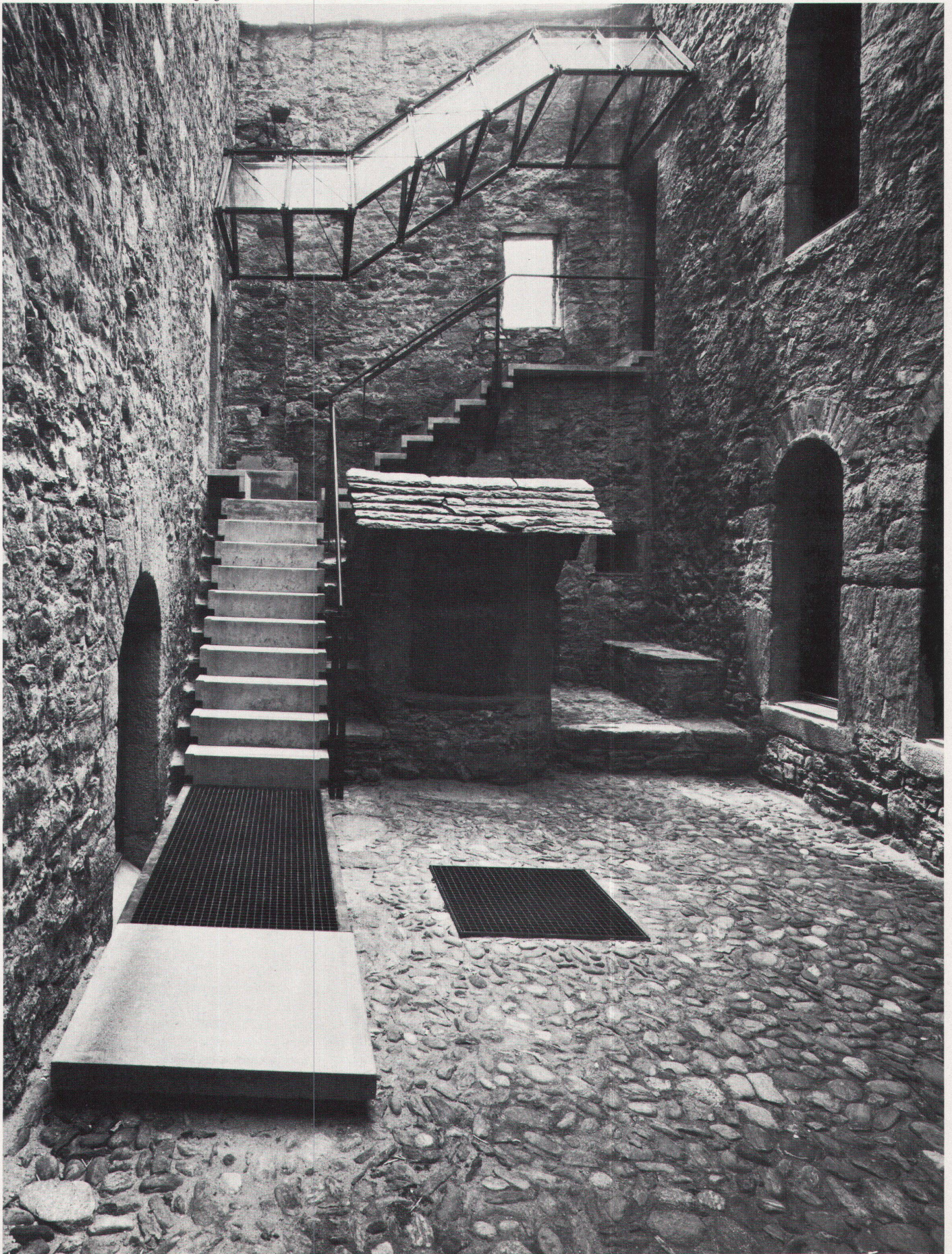
3 Innenhof mit Ziehbrunnen. Zugang zum Turm (links) und Palazzetto (rechts)
