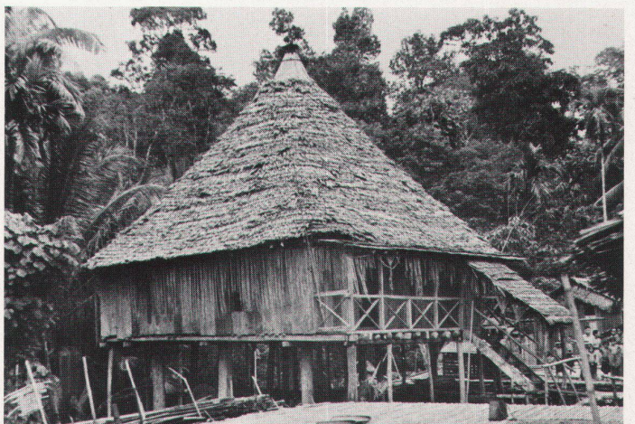
5 Pour éviter l'humidité, le sud-est asiatique et les îles recourent aux pilotis: maison des Dayaks de Bornéo. (Photo: W. R. Geddes)
