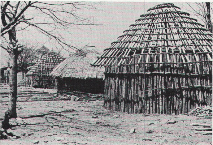
4 Une hutte plus perfectionnée – le toit est distinct des murs porteurs – édifée en rondins et en chaume, le long du Zambèze, en Mozambique. (Photo: James Barr)
