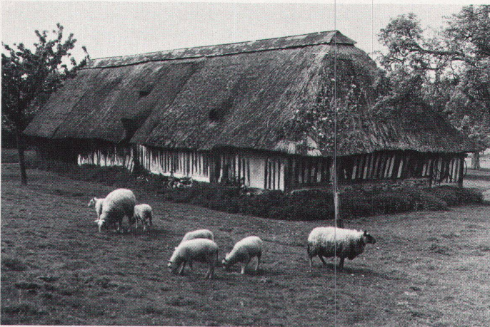
7 La ferme traditionnelle de Normandie n'est guère éloignée de la hutte: elle a conservé les éléments de rondins et de chaume. (Photo: Libor Sir)
