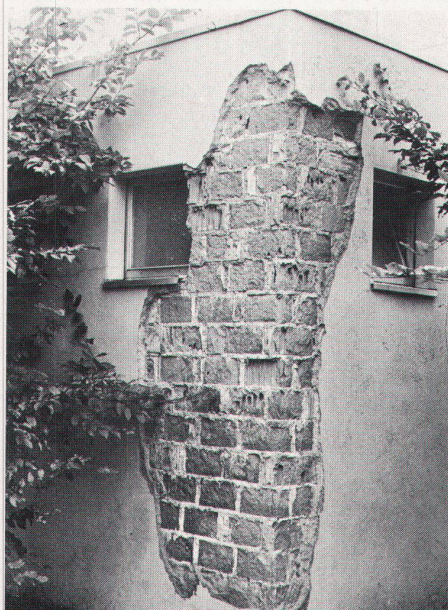
10, 11 Les limites de la technique et les méfaits du gel: bâtiment dans la région de Bienne présentant un décollement du crépissage dû au gel qui a fait sauter les briques. (Deux documents communiqués par le Laboratoire d'essai des matériaux pierreux de l'EPFL.)
