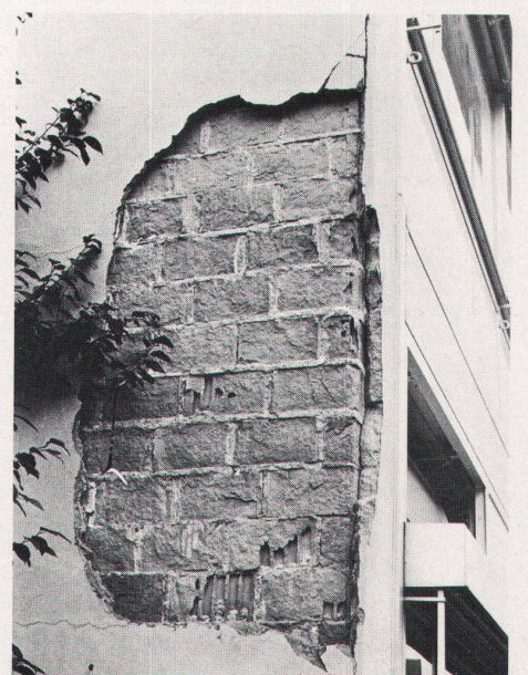
10, 11 Les limites de la technique et les méfaits du gel: bâtiment dans la région de Bienne présentant un décollement du crépissage dû au gel qui a fait sauter les briques. (Deux documents communiqués par le Laboratoire d'essai des matériaux pierreux de l'EPFL.)
