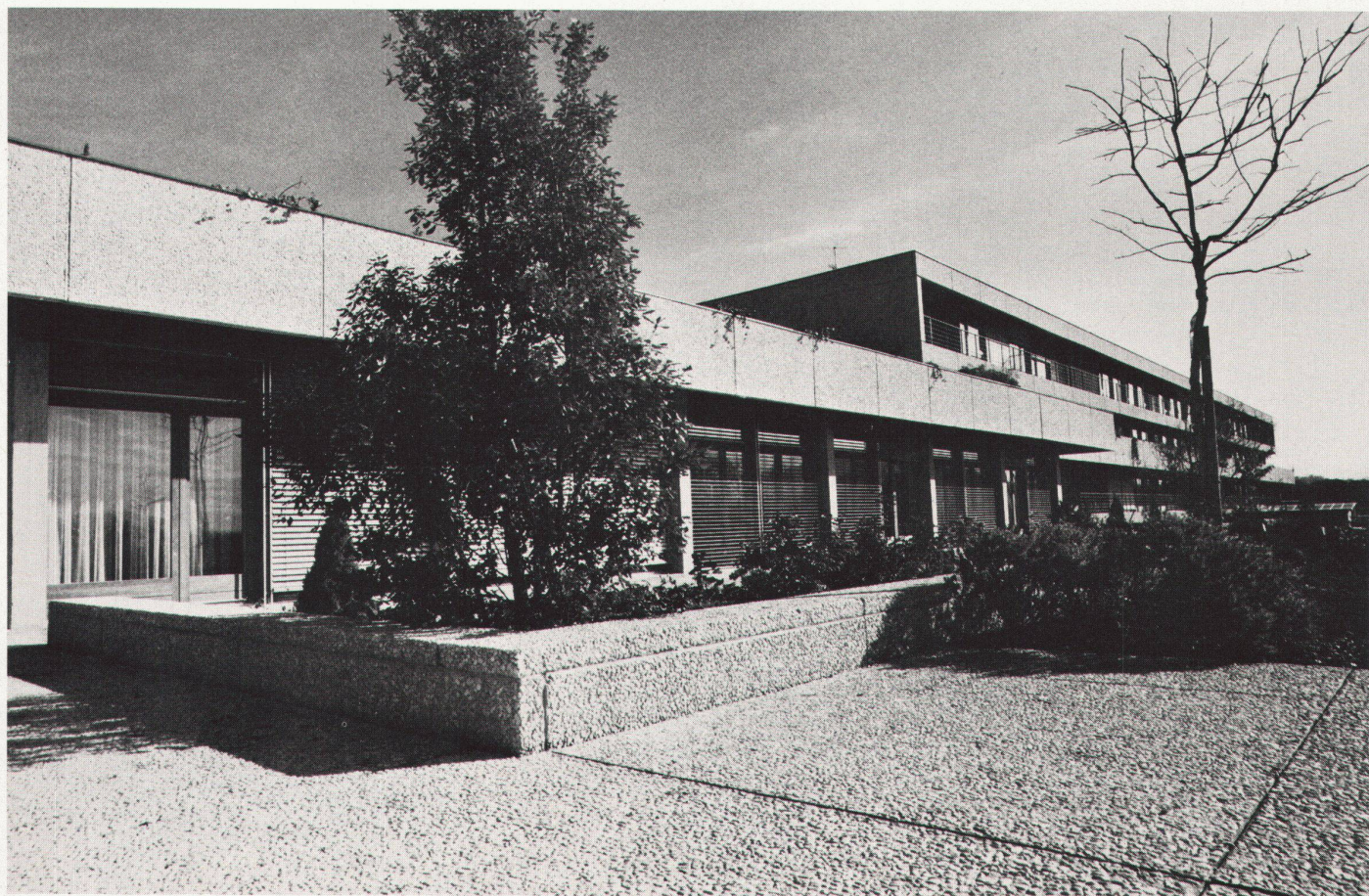
Vue sur la façade principale internat
