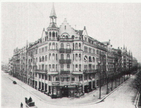
2 Strassenkreuzung in Zürich-Wiedikon um 1910
