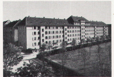
4 Wohnkolonie Ottostrasse an der Ottostrasse/Neugasse/Josefstrasse, Zürich 5
