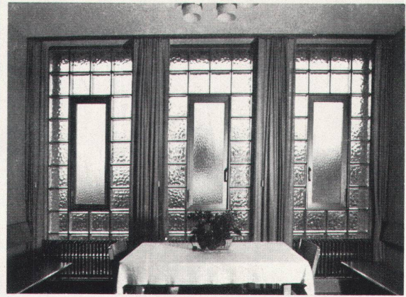
Glasbausteinfenster mit Anticorodal-Drehflügel in Sitzungszimmer.
