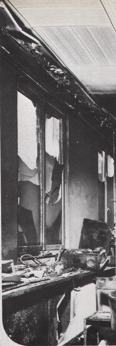
Die über der PAVAROC-Decke liegenden, mit Oelfarbe gestrichenen Deckentäfer sind unversehrt.
