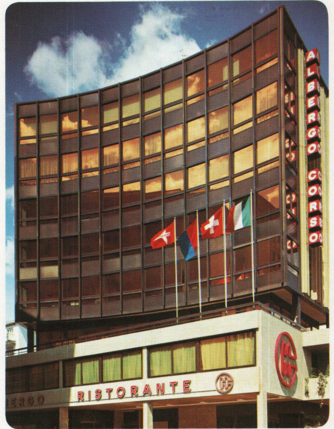
Immobile Commerciale Al Corso S.A. Chiasso – Schweiz, 1973 INFRASTOP-Gold 40/26 – Studio Grassi + Co., Chiasso
