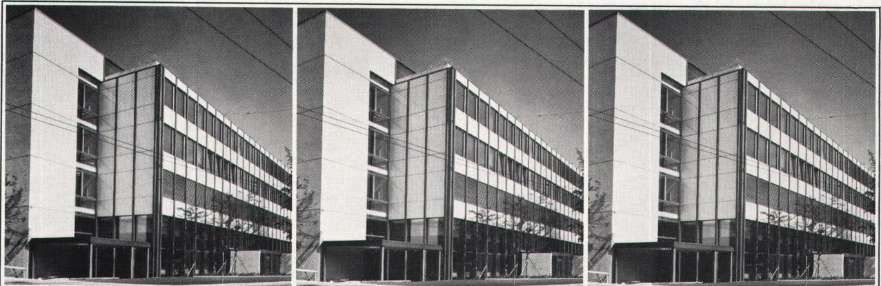
*Die Firma Geilinger (Geilinger & Co., Metallbau, Winterthur) lieferte Brüstungsverkleidungen (750m<sup>2</sup>), Stützenverkleidungen (380 Stück) sowie Leichtmetall- und Holz/Metall-Fenster (2400m<sup>2</sup>).*
