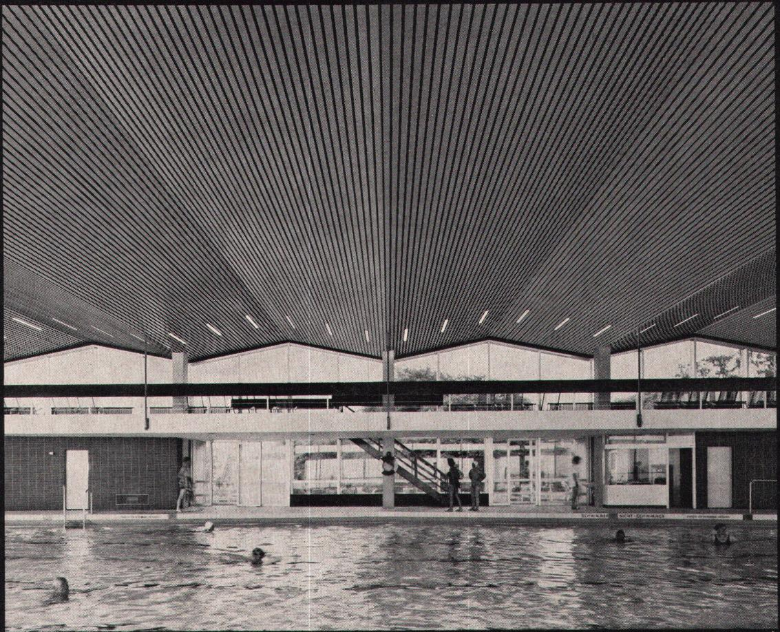
Luxalon® Aluminium-Decken. Das heisst einbrennlackierte Aluminiumpaneele, die auf einbrennlackierte Aluminiumtragschienen geklemmt werden. Dabei stehen unterschiedliche Profilformen zur Wahl. Luxalon® Aluminium-Decken. Das heisst hohe Korrosionsfestigkeit. Einfache und schnelle Montage, bietet vielfältige Gestaltungsmöglichkeiten. Leitungen und Installationen bleiben also immer zugänglich. Und noch ein Vorteil: Luxalon® Aluminium-Decken sind in verschiedenen Farben erhältlich.
