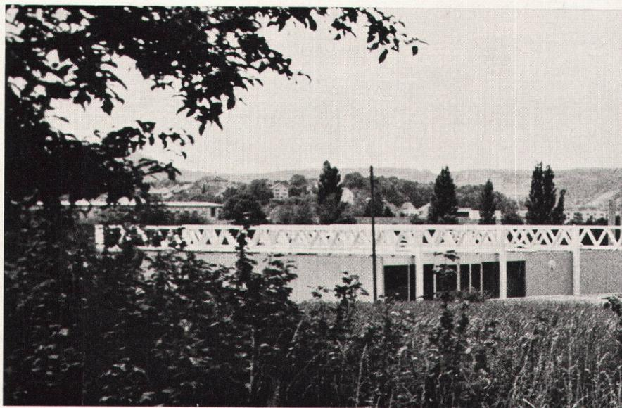
Die erste Etappe der Oberstufenschulanlage Brüel in Gebenstorf umfaßt 8 Klassenzimmer, Bibliothek und 2 Handfertigkeitsräume sowie die zum Turnhallentrakt erweiterbare Turnhalle. Das Hauptgebäude ist eine Stahlkonstruktion mit Fertigelementplatten, die Erschließungstürme mit den Installationen sind aus dem Gebäude herausgenommen und in Massivbauweise erstellt
