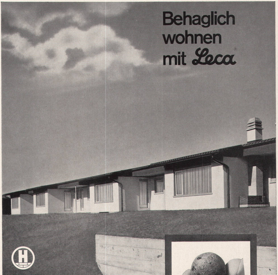
Reihen-Einfamilienhäuser aus vorfabrizierten Leca -Elementen Architekt: Planungsbüro Mani, Rüfenacht BE
