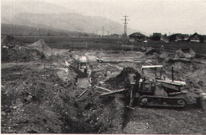
5 Erschließung der Industriezone in Giswil OW
