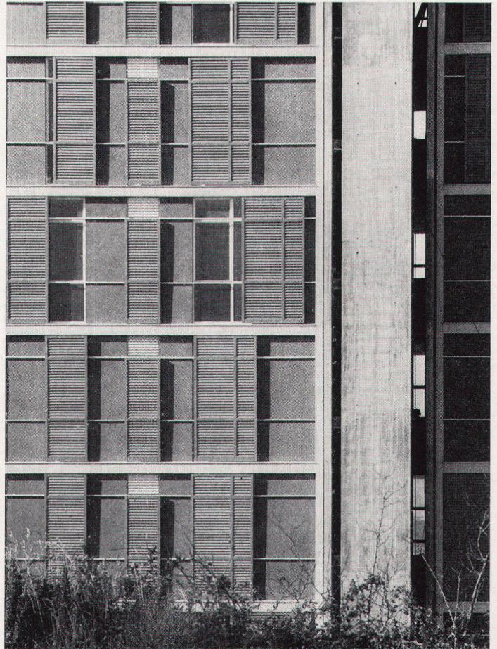
Die undurchsichtigen Außenwände der Wohnungen sind Sandwichplatten mit Kunststofffüllung und nach außen mit einem undurchlässigen Granulat bestrichen; dazwischen sind vom Boden zur Decke durchgehende Fensterwände mit verschiebbaren Läden
