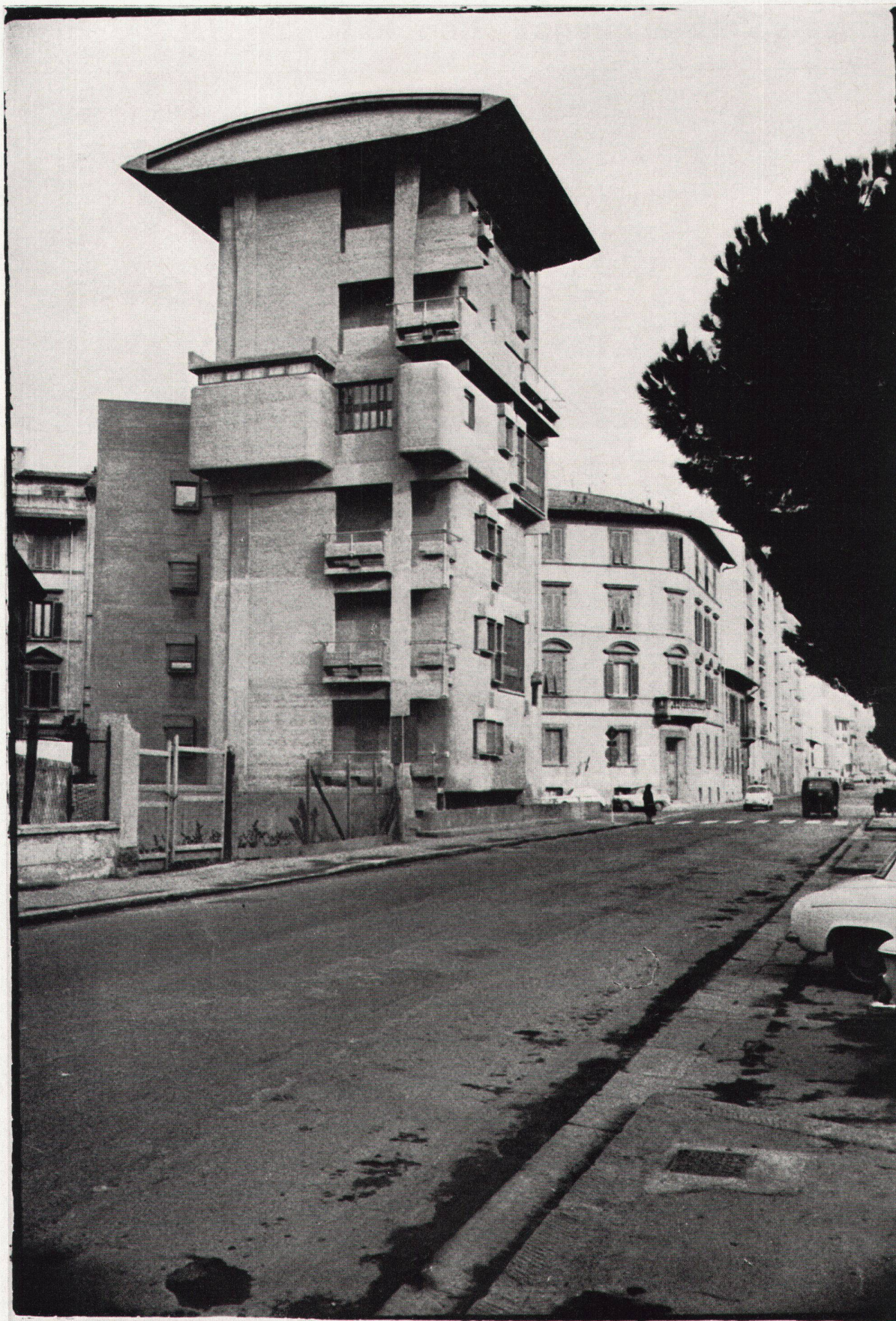
werk 7/1971 Wohnhaus an der Via Piagentina in Florenz
