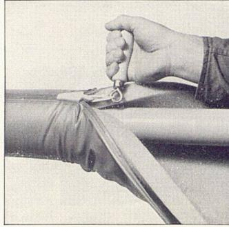
die Rohrisolierung mit Gleitverschluß,
