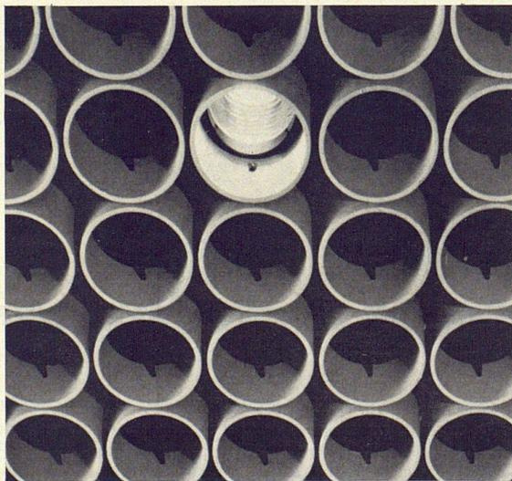
Die Beleuchtungskörper,  $\varnothing$  zirka 18 cm, wurden direkt im Diagonalschnittspunkt der Rasterfelder in die Rohrstücke eingebaut.
