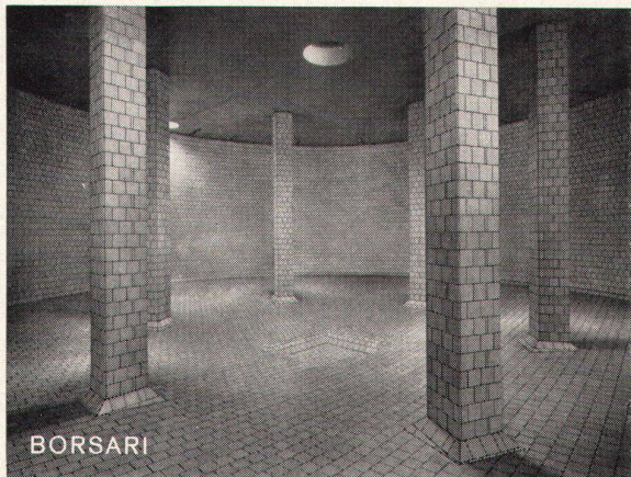
Flughafen-Immobilien-Gesellschaft Zürich-Kloten 7 Tanks total 5600 m 3 Schweröl
