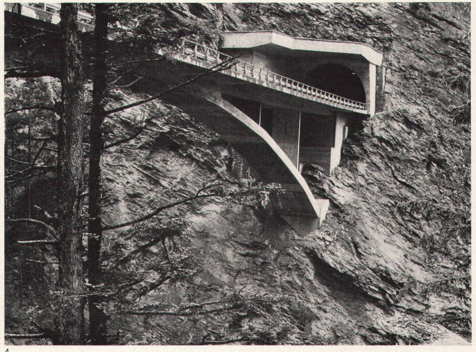
tale Abweichungen gegenüber der Gewölbeachse aufweist, war es zweckmäßig, die ersten Bogenstützen erst in einiger Entfernung von den Gewölbefundamenten anzusetzen, wie dies aus der Längsschnittszeichnung ersichtlich ist.
