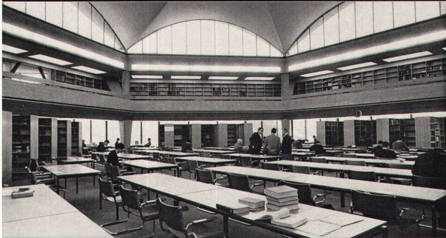
Neubau Universitätsbibliothek, Basel Architekt: Otto H. Senn, BSA, Basel
