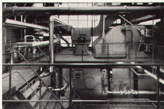
Beim Neubau der Genfer Kehrichtverbrennungsanlage spielte der Korrosionsschutz eine wichtige Rolle. Maschinen und Installationen mussten gegen Hitze, Rauchgas, Kondenswasser, Chemikalien usw. wirksam geschützt werden.
