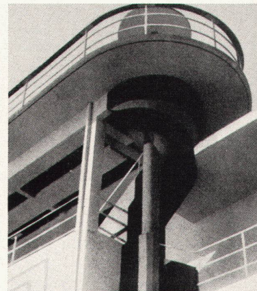
5 Projekt «Weiße Türme» mit aufgehängten Geschossen. Architekt: Saez de Oiza
