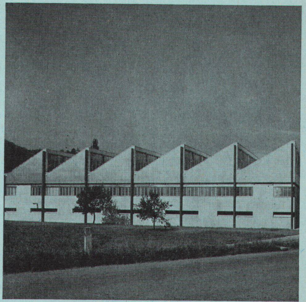
Werkstattgebäude der Sauerstoff- und Wasserstoff-Werke AG, Luzern, in Kriens. Architekt: Wolfgang Behles, Zürich
