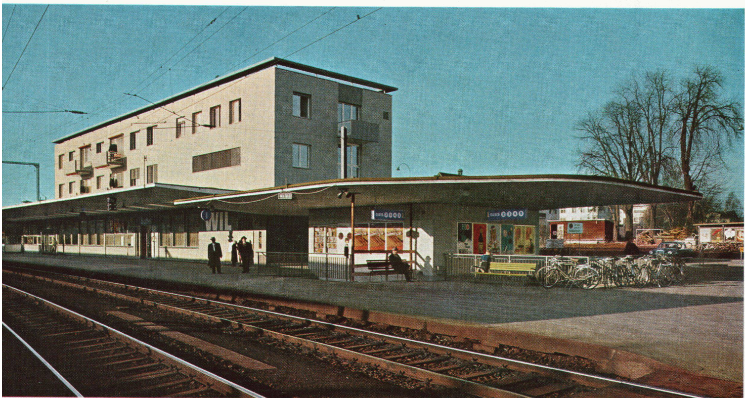
Bahnhof SBB, Wil/SG ausgeführt in Durisol-Mauerwerk
