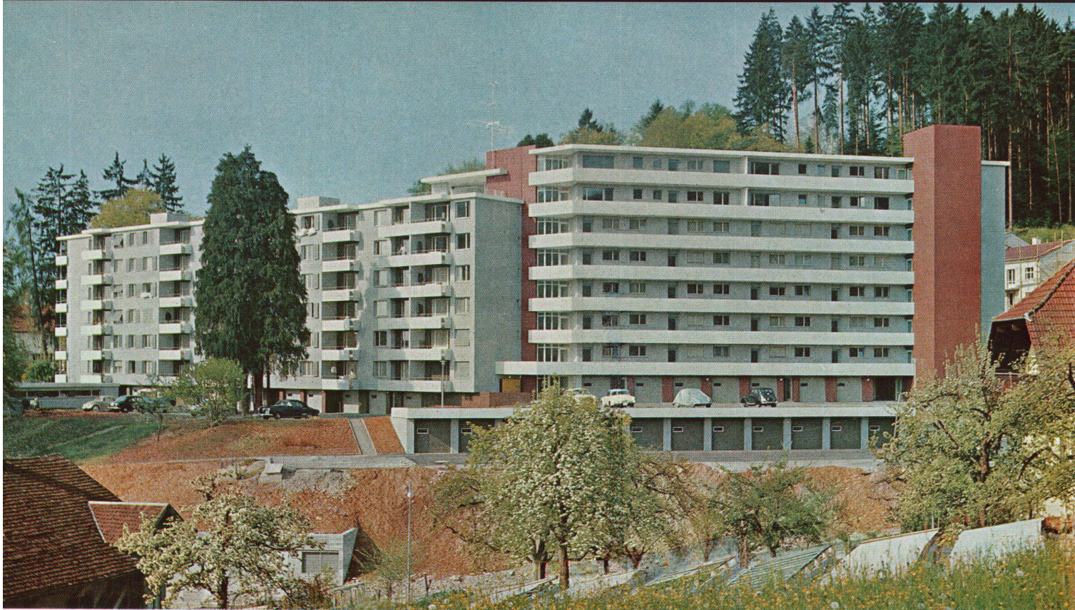
Überbauung Tannengut, Aarau ausgeführt in Durisol-Mauerwerk
