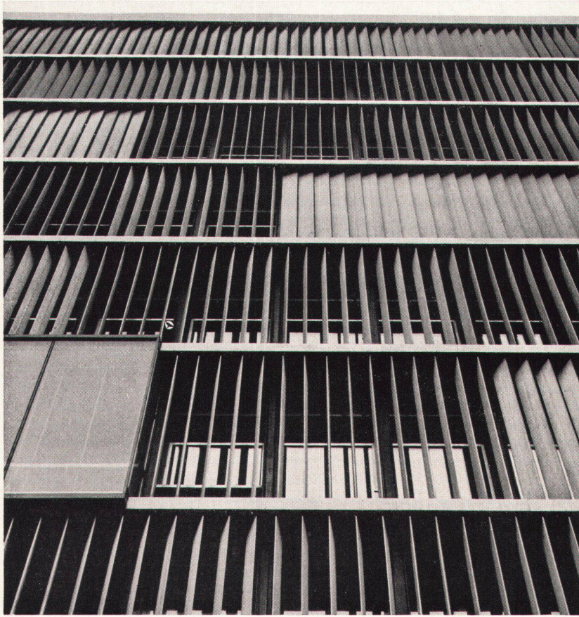
1 Verwaltungsgebäude der Olivetti in Mailand, Südfassade mit Lamellen. Architekten: Bernasconi, Flocchi, Nizzoli Bâtiment administratif Olivetti à Milan, face sud à lamelles Olivetti administration building in Milan, south elevation with lamellae
