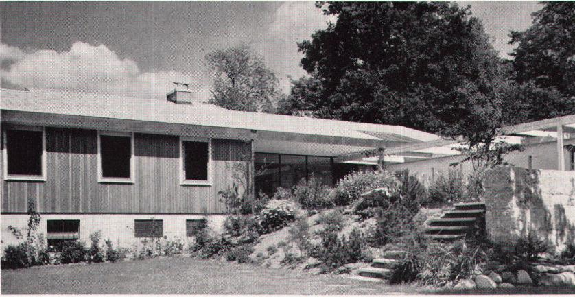
unverputztem Beton. Das Dach wurde mit naturgrauem Eternit eingedeckt und die Spenglerarbeiten in Kupfer ausgeführt. Auf gute Schall- und Wärmedämmung wurde besonders geachtet. Die neuzeitliche Warmluftheizung erlaubt auch im Winter ein behagliches Wohnen. Umbauter Raum nach SIA: Wohnhaus 1080 m<sup>3</sup>, Garage 120 m<sup>3</sup>.
