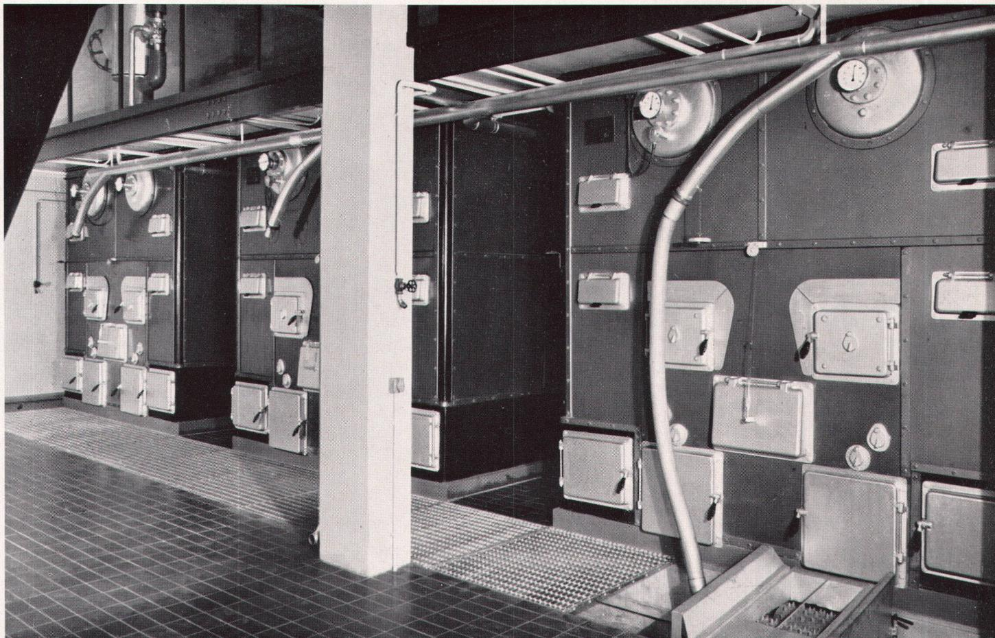
Für das gesamte Areal der sogenannten Sandgrube in Basel wurde eine Fernheizungszentrale erstellt. Sie verbrennt grobkörnigen Koks. Die neuen Gebäulichkeiten der Gewerbeschule, d. h. zwei 7geschossige Schultrakte und fünf 1geschossige Werkstatttrakte, sowie das Schulhaus Sandgrube mit allen Nebengebäuden werden von dieser Zentrale mit Wärme versorgt.
