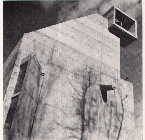
20 Ostseite der Kirche mit Glockenträger Face est de l'église avec les cloches East elevation of church with bells
