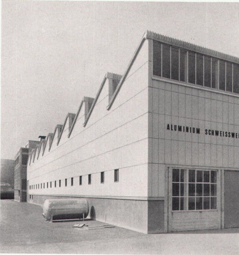
Die nicht unterkellerte dreischiffige Shedhalle dient der Fabrikation von Aluminiumtanks.
