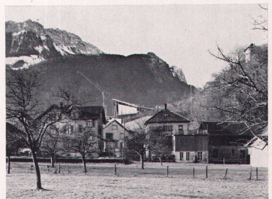
5 Bauzustand Frühling 1956 Etat de la construction au printemps 1956 Stage of erection in spring 1956 Photo: H. Schönwetter, Glarus
