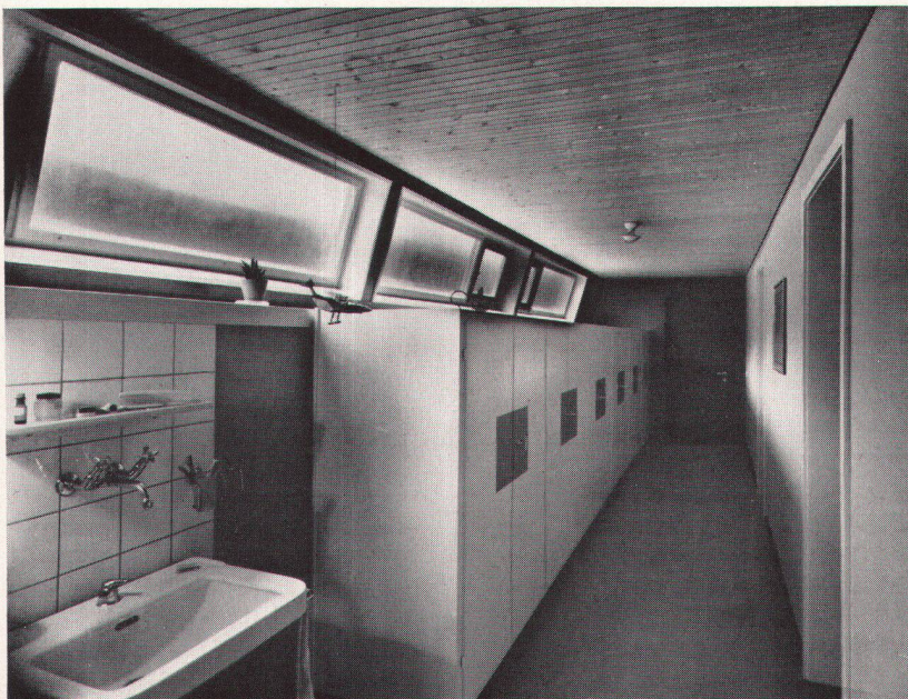
13 Korridor Schlaftrakt Corridor, aile des chambres à coucher Corridor of bedroom wing
