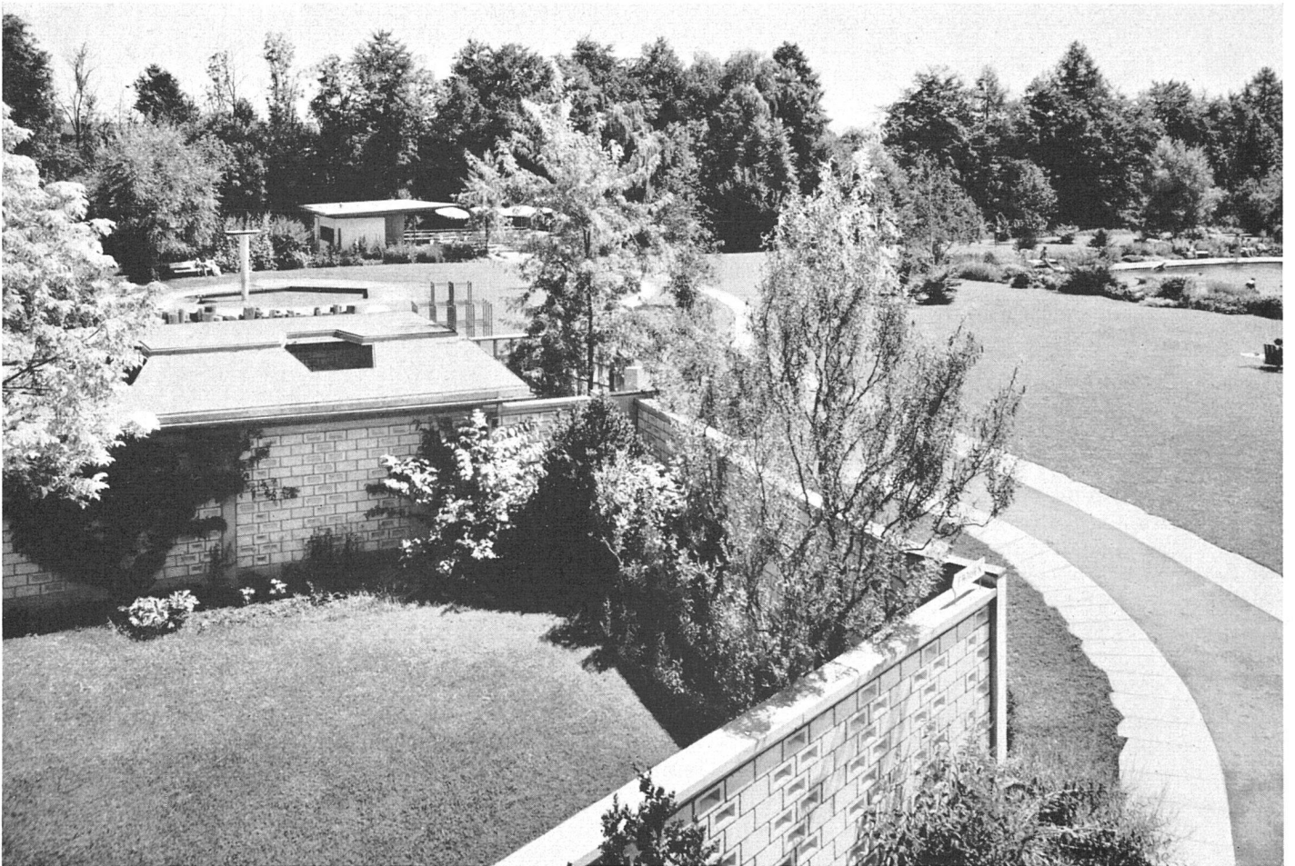
Schwimmbad Dübendorf. Blick über Mädchengarderobe auf Restaurant | Piscine à Dübendorf; au premier plan, le vestiaire des filles, au fond, le restaurant | Open-air bath at Dübendorf; foreground, girls' cloakrooms, background, the restaurant
