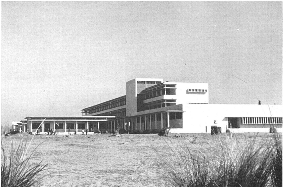
Technikum; links Werkstätten (Architektenkollektiv) | Technicum; à gauche, les ateliers | Engineering college, on left, workshops
