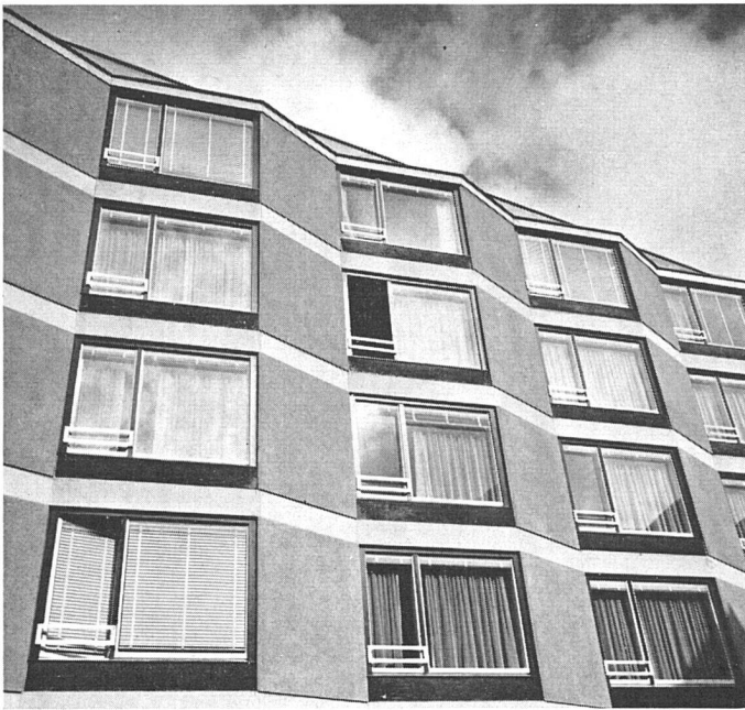
Ausschnitt Südwestfassade, vorgefertigte Betonelemente | Façade sud-ouest, détail | Detail of south-west elevation
