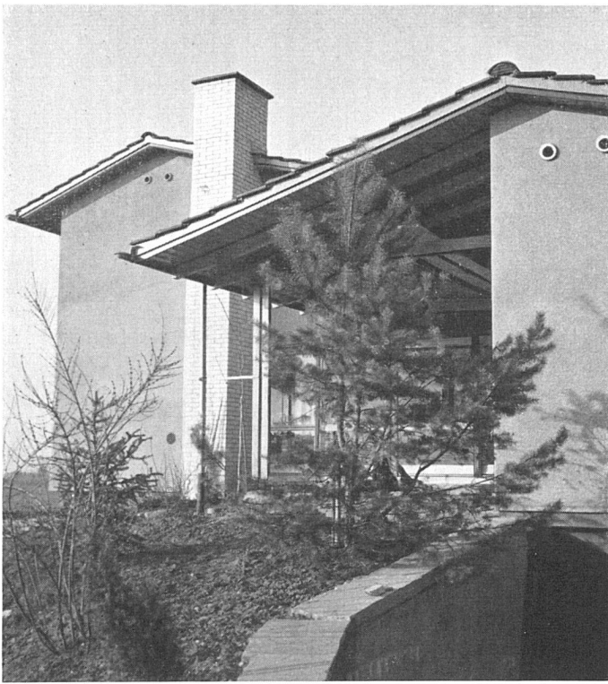
Detail Gartensitzplatz | Terrasse couverte; détail | Detail of covered terrace
