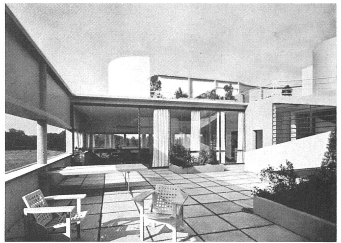
7 Haus in Poissy bei Paris. Le Corbusier, 1930. Terrassenraum mit Rampe zum Sonnenbad | Maison à Poissy, terrasse-jardin avec rampe conduisant au solarium | House at Poissy, roof-garden terrace with ramp leading to the sun deck
