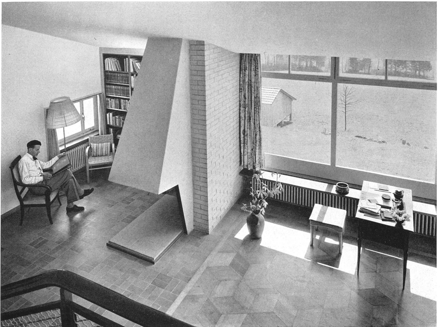
Wohnraum, vom Treppenpodest aus gesehen | Grande salle | Living-room
