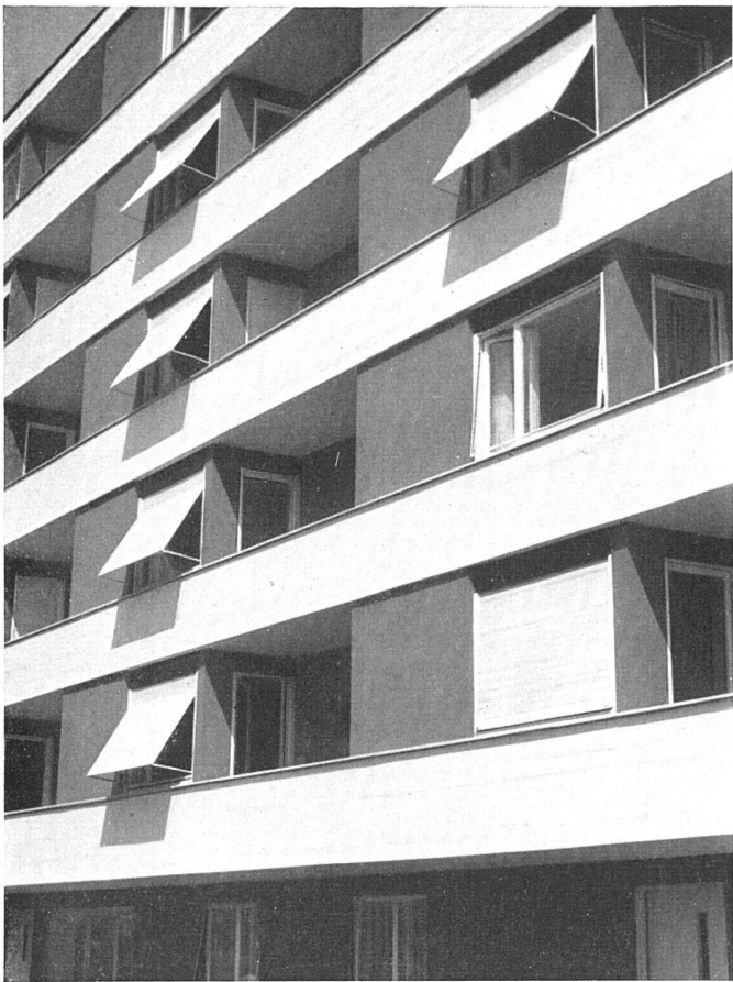
Ausschnitt Westfassade / Façade ouest; détail / Detail of main elevation
