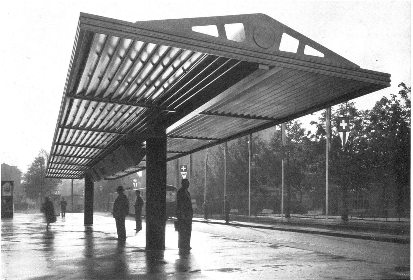
Das Perrondach vor dem Mustermessegebäude in Basel, System «Shadelite», ganz aus Aluminium, Säulen schwarz / Arrêt de tramway abrité à Bâle, système «Shadelite», exécuté entièrement en aluminium / Tramway station in Basle, system: «Shadelite», prefabricated aluminium construction
