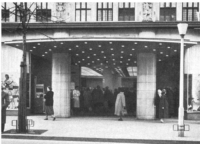
Der umgestaltete Haupteingang an der Bahnhofstraße, türlos mit Luft- vorhang / La nouvelle entrée principale à rideau d'air, sans portes / The remodelled main entrance with air curtain, no doors
