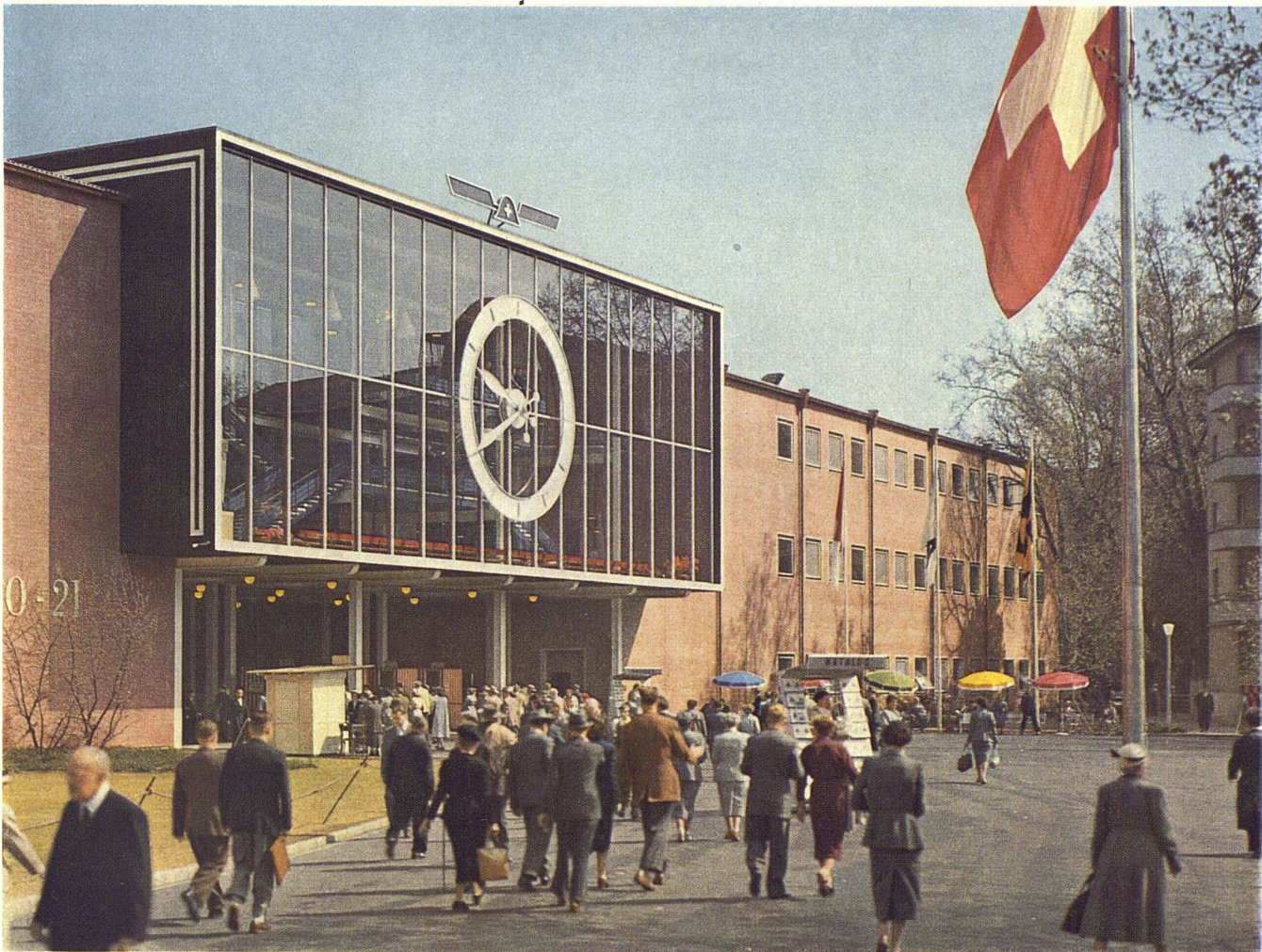
Gesamtansicht mit Haupteingang an der Rosentalstraße | Façade sud et entrée principale | South elevation with main entrance
