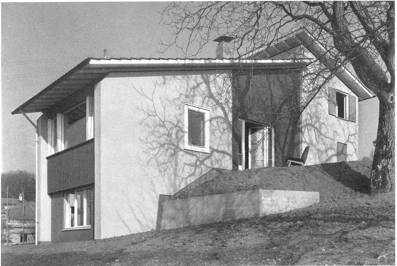
Gesamtansicht von Südwesten / Vue prise du sud-ouest / General view from south-west
