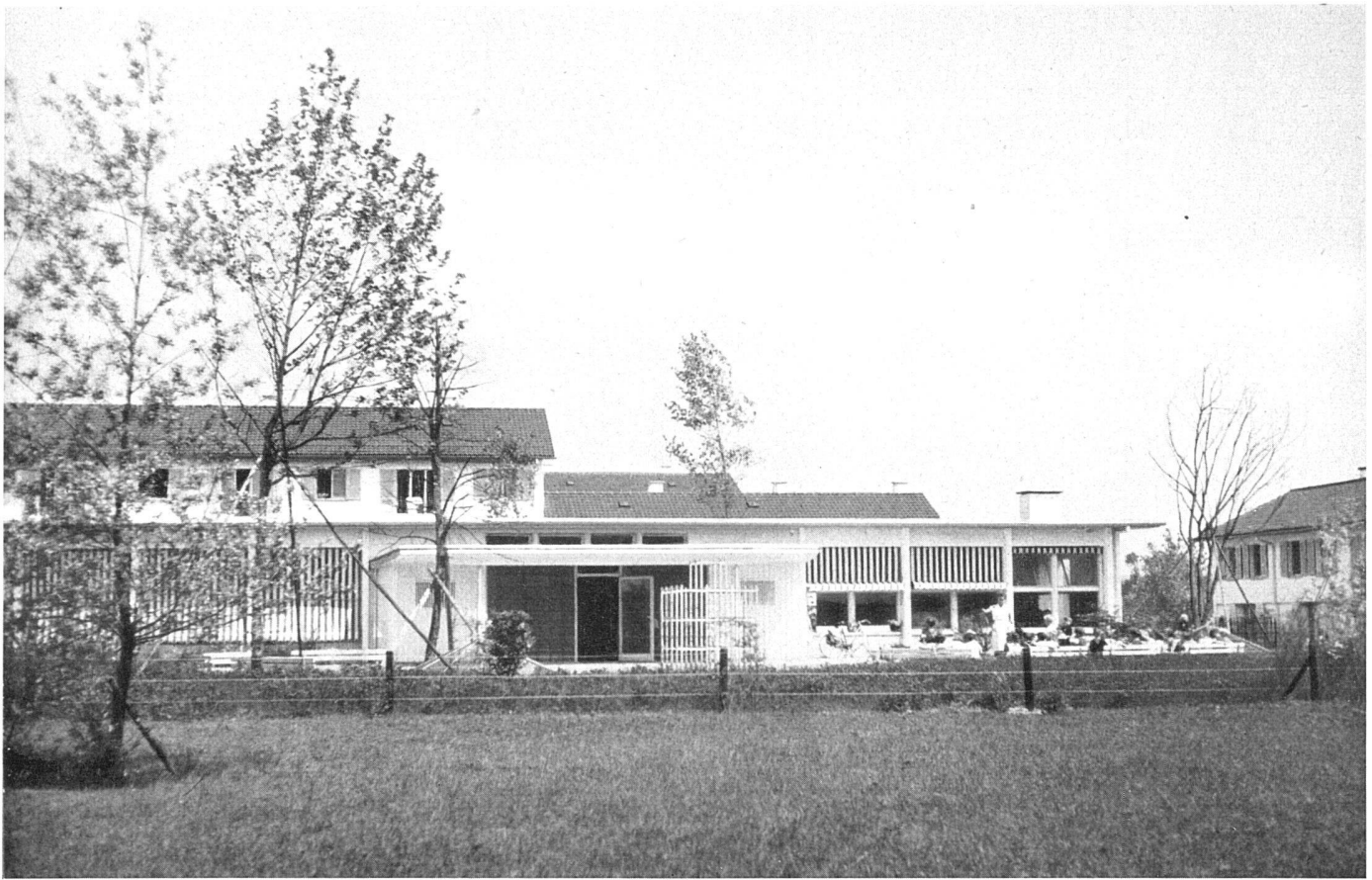
Kindergarten in der Siedlung am Glattbogen, von Süden gesehen | Vue prise du sud du jardin d'enfants de la colonie de Glattbogen | The kindergarten of the Glattbogen settlement from the south
