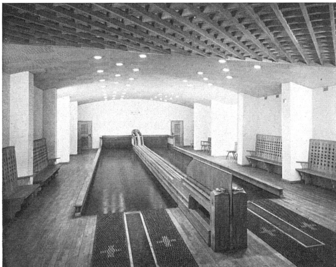
Kegelbahn, Untergeschoß Vorderhaus, schalldämpfende Deckenkonstruktion | Jeu de quille au sous-sol de l'aile basse | Skittle-alley on basement floor of low wing
