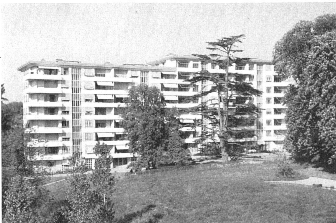
Immeubles à sept étages Deux-Parcs-Lac à Montchoisy 1950, Honegger, frères, ing. et arch., Genève | Wohnbauten im Quartier Montchoisy, 101 Wohnungen in 5 Bauten | Block of flats, south elevation
