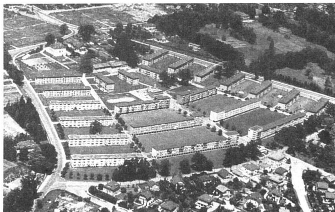
Cité Vieusseux, groupe d'immeubles à trois étages, 1930/31, M. Braillard, Gampert et Baumgartner (†), L. Vincent (†), Ch. Mezger. Au fond et en haut, les étapes de 1947/50, E. Martin | Wohnquartier Vieusseux | Vieusseux settlement Photo: Albert Grivel, Genève
