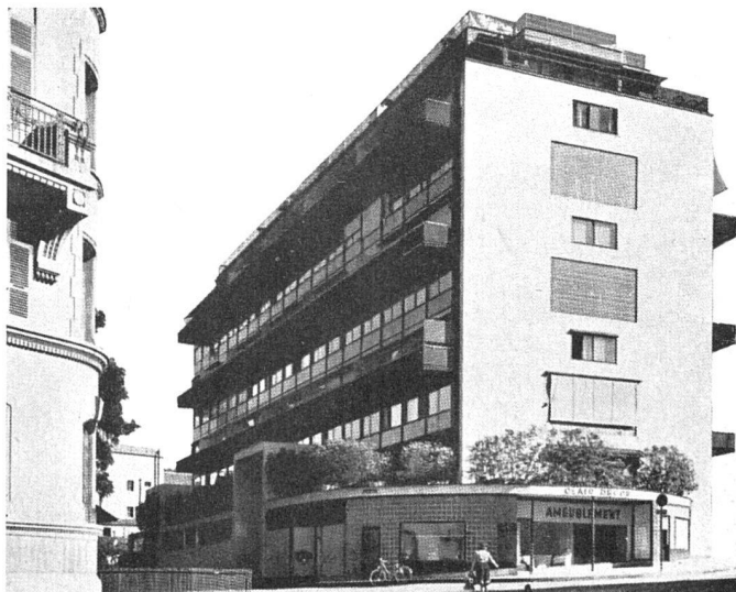
Immeuble Clarté, 1930/32, Le Corbusier & P. Jeanneret, Paris. Une des premières réalisations modernes de bâtiment à multiples étages | Einer der ersten modernen vielgeschossigen Wohnbauten in Genf | One of the early modern multi-storey blocks of flats
