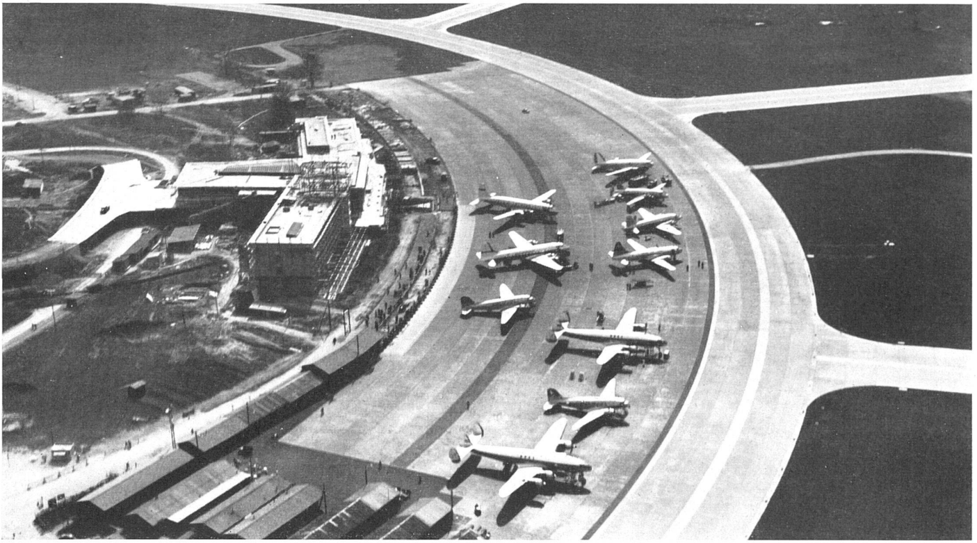
Bauzustand vom Mai 1952. Die Anlage soll auf Ende Jahr fertig werden. Der Passagiertrakt befindet sich im Zentrum in Querlage zum nähergelegenen Büro- und zum fernereren Restauranttrakt, die parallel zum Flugsteig liegen, links außen Zu- und Wegfahrt | Etat des travaux en mai 1952 | Build-ings in May, 1952
