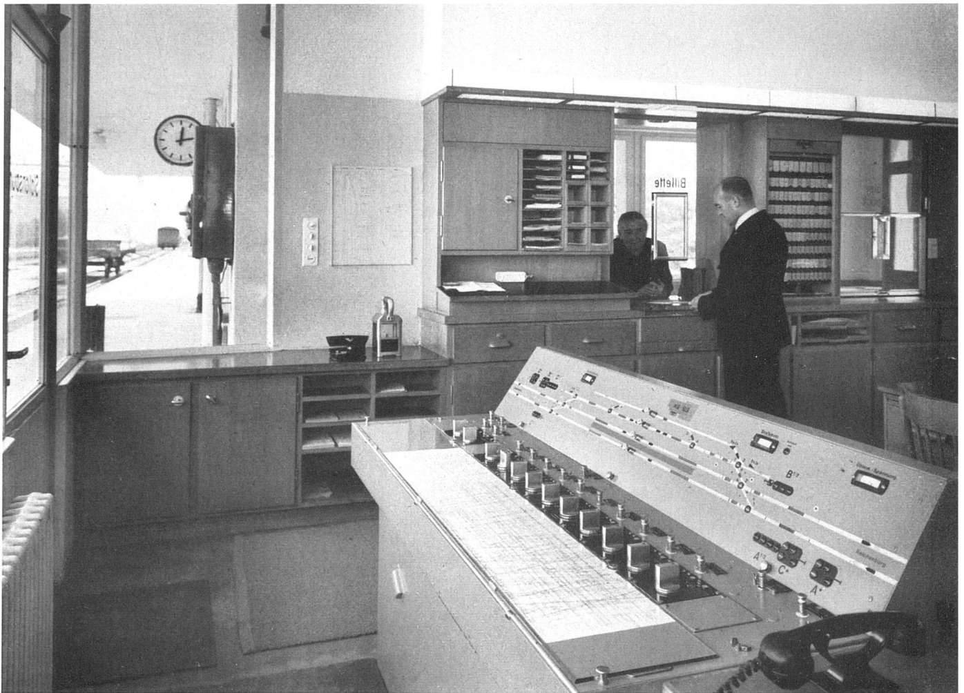
Das Stationsbüro als Zentrum der Kleinstation. Im Vordergrund das Pultstellwerk | Le centre de la petite gare en est le bureau; au premier plan, le tableau d'aiguillage | The station office as centre of the small station. Foreground, the signal-box controls
