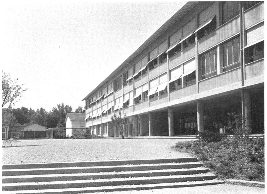
Der Klassentrakt von Nordosten | Le bâtiment principal vu du nord-est | The main building from north-east
