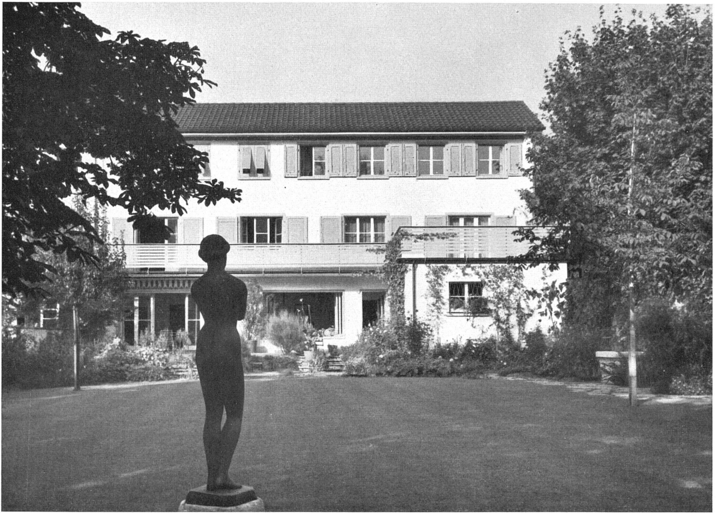
Gesamtansicht von Süden und vom Garten, im Vordergrund Skulptur von W. Wolf, Wien | Vue générale sud, prise du jardin | South and garden elevation
