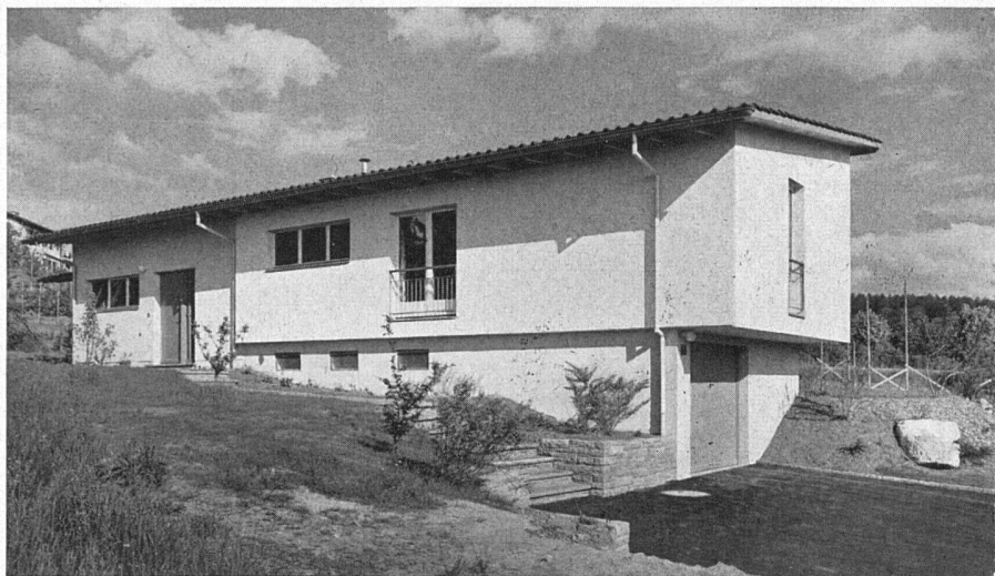
Ansicht von Westen mit abgesetztem Schlafzimmertrakt | Façade ouest montrant le décrochage de l'aile des chambres à coucher | View from west
