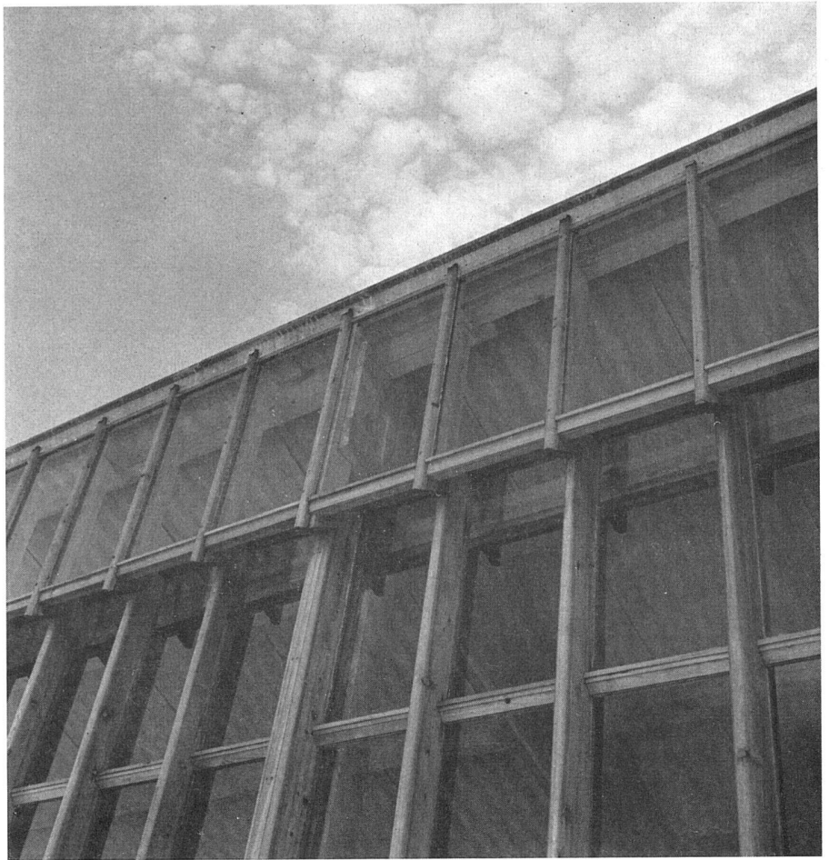
Ausschnitt aus dem festverglasten Fensterband mit Lüftungsschlitz | Détail des fenêtres à vitrage fixe et fente d'aération | Section of row of fixed windows with ventilation slot
