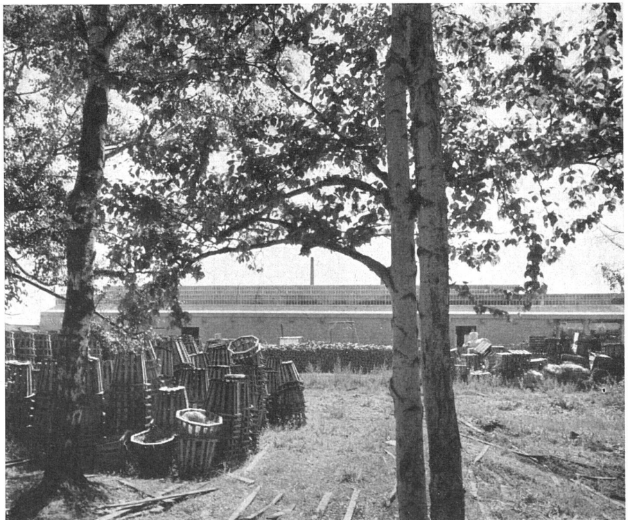
Ansicht der vom Meer abgewendeten Längsseite | Façade principale détournée de la mer | Long side of warehouse facing inland
