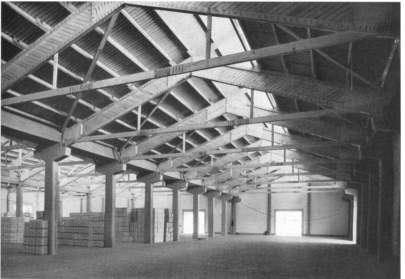
Inneres des niederen Traktes, mit Blick gegen Anfahrt | Intérieur de l'aile basse avec vue sur l'entrée des voitures | Interior of low wing looking towards entrance
