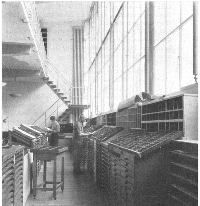
Setzerei, nach Norden orientiert. Setzkästen unter den Fenstern | Salle de composition, orientée vers le nord. Casses sous les fenêtres | Composing room, facing north. Type cases under the windows
